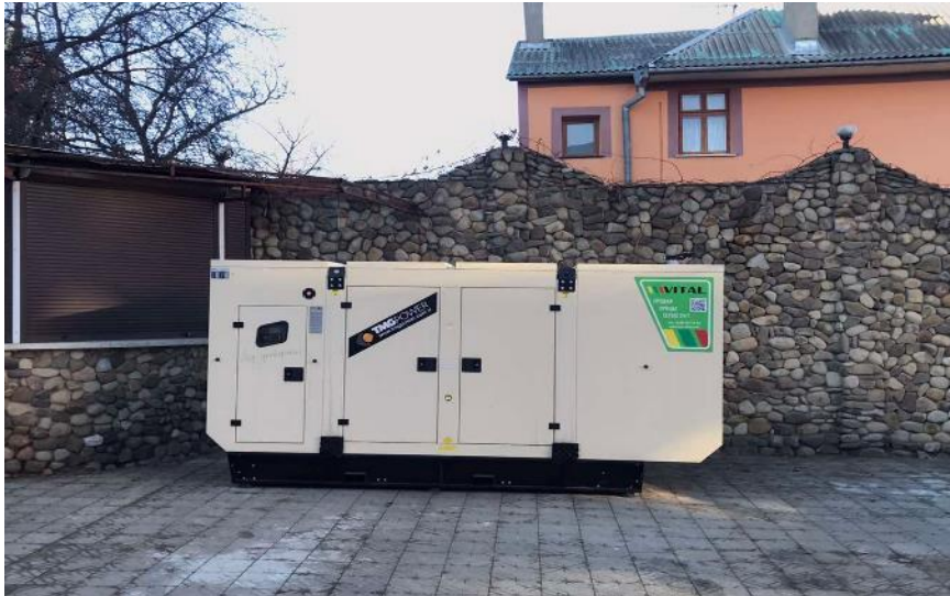
Котельня по вул. Чорноморській, 13 Б
