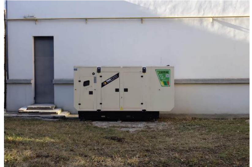
Навчальний корпус по вул. Богомольця, 2
