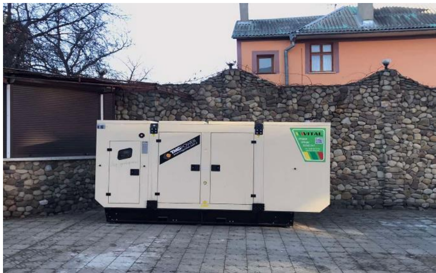
Котельня по вул. Чорноморській, 13 Б
